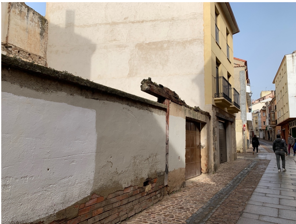
Solares vacíos y restos con vigas en mal estado
