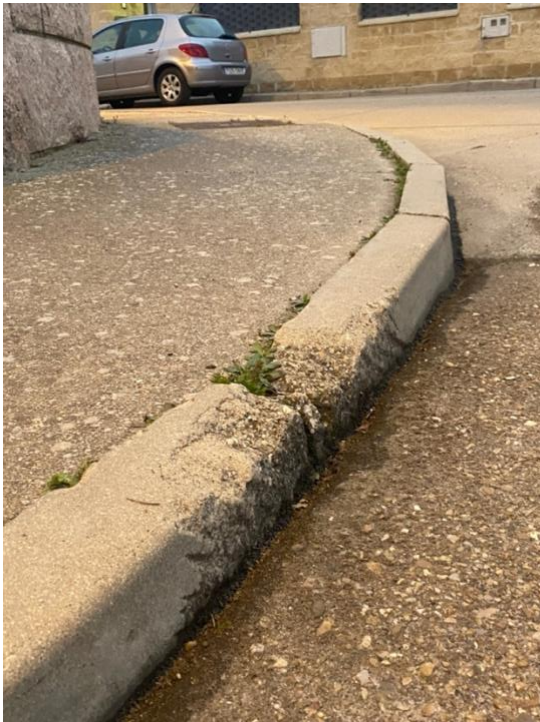
Bordillos y aceras desgastados por el paso del tiempo y baldosas rotas por falta de mantenimiento.
